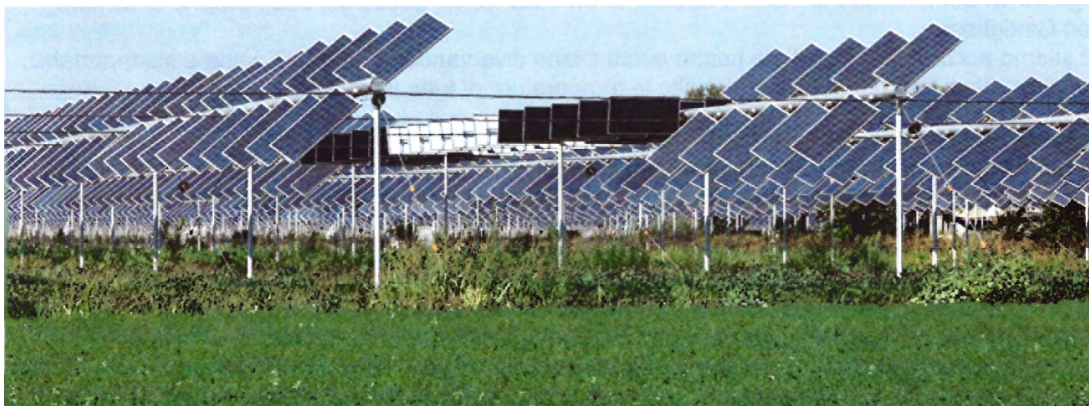
Esempio di installazione di pannelli che consentono le lavorazioni del terreno sottostante
